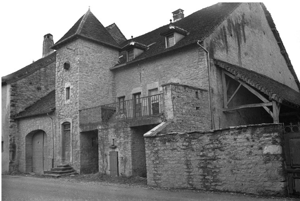
Maison du 17e ou du 18 siècle.
