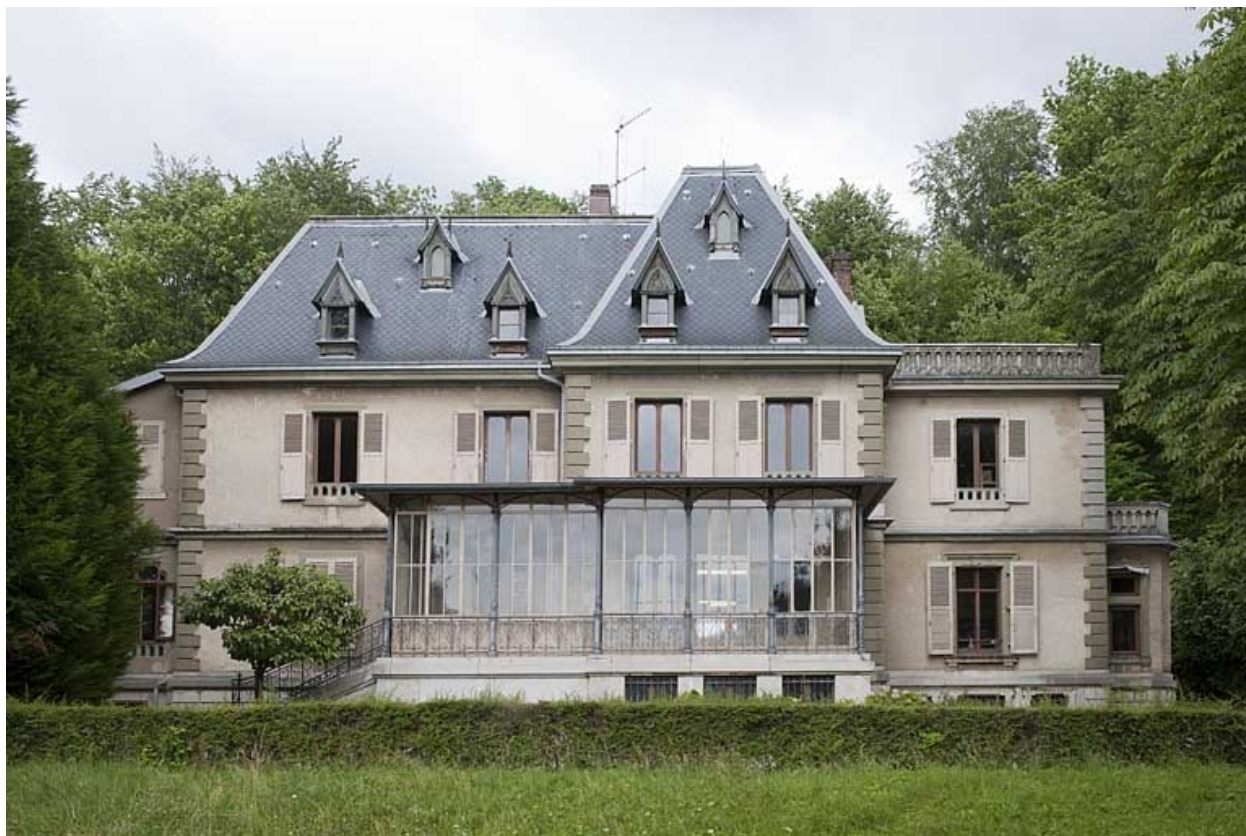
Façade antérieure depuis l'ouest.
