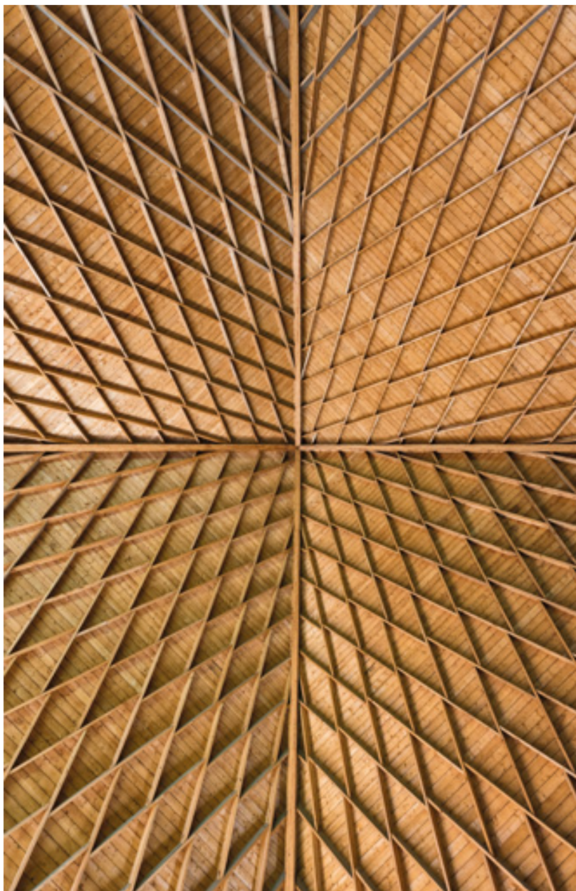
Charpente. Vue en contre-plongée.
