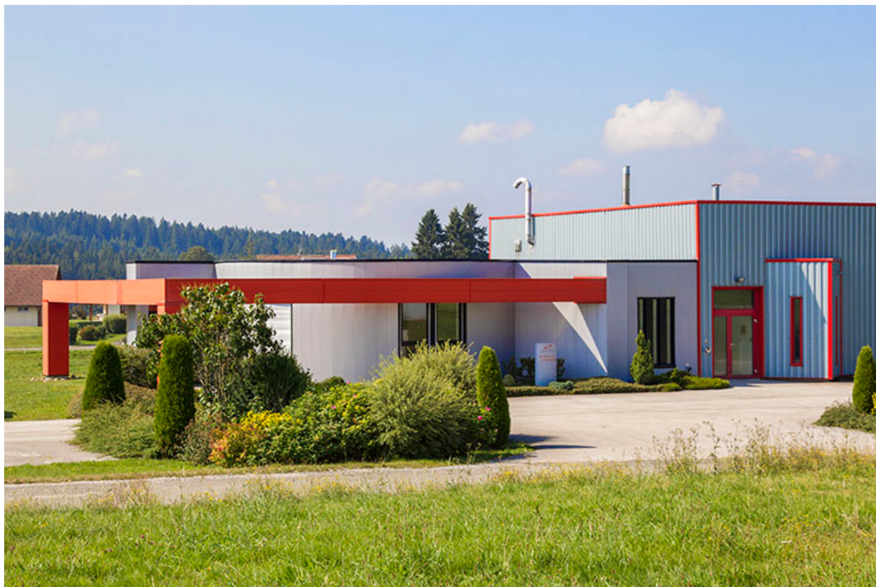
Façade antérieure : bureaux et entrée.
