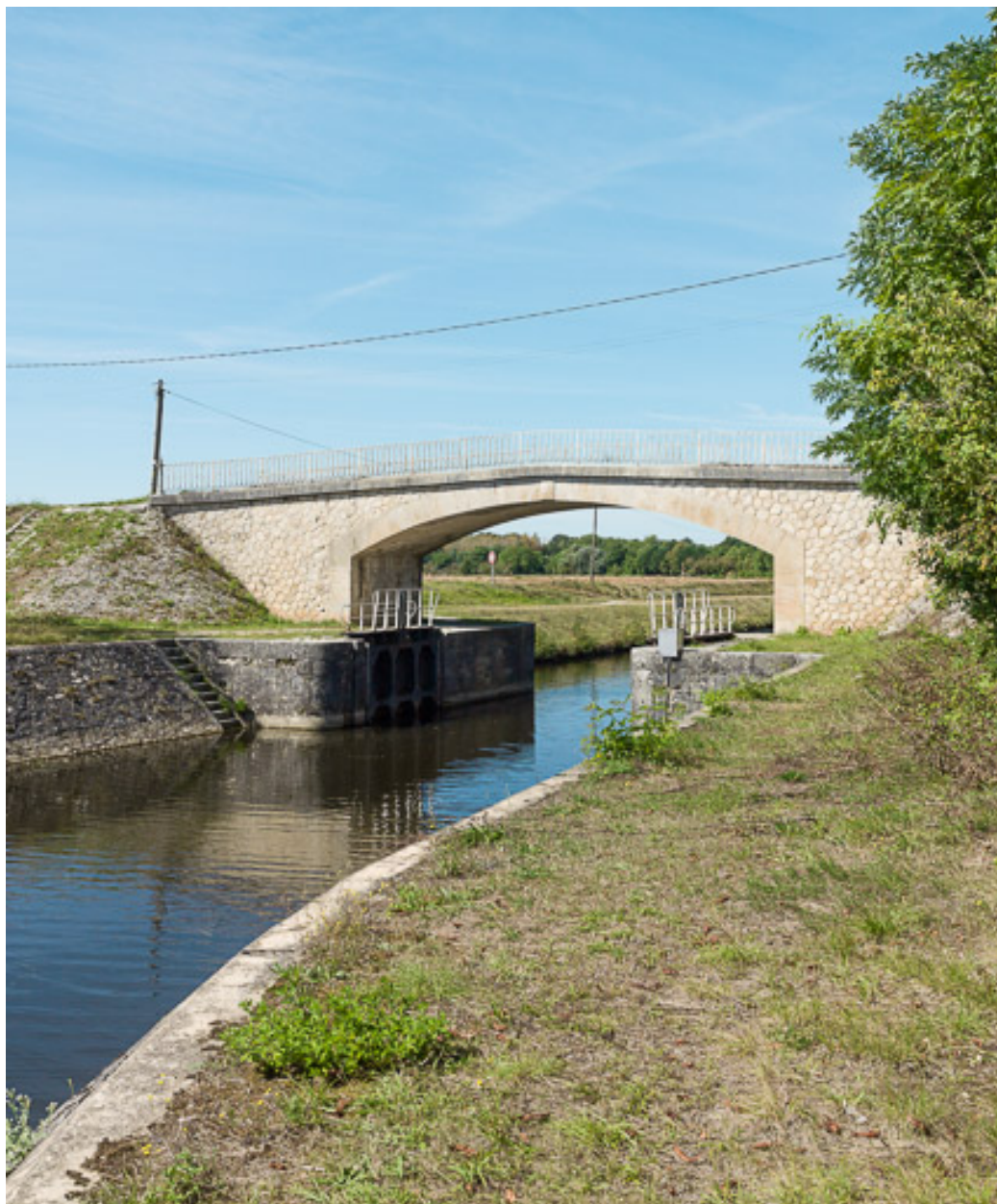
Vue d'ensemble du pont.
