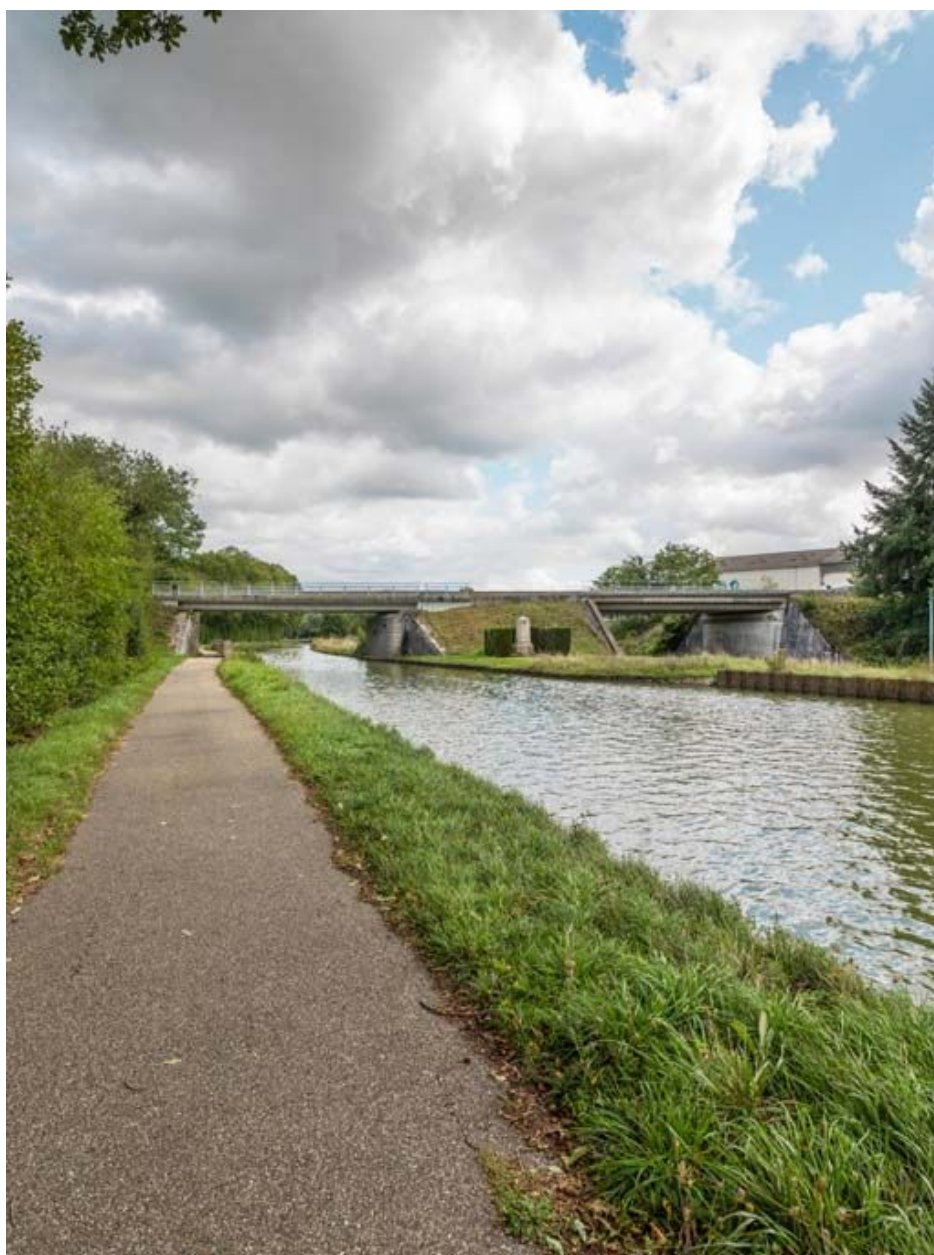
Vue d'ensemble du pont.
