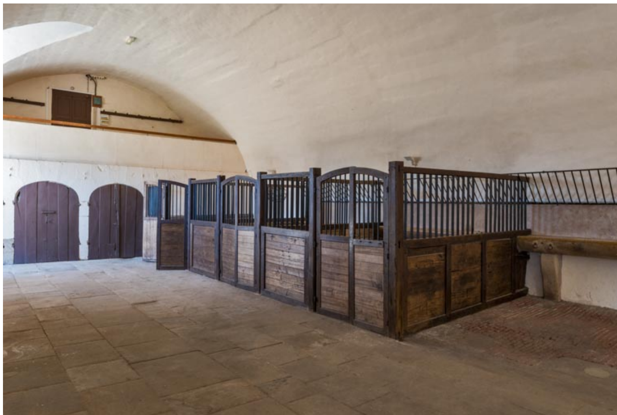
Ecurie, partie occidentale : stalles.
