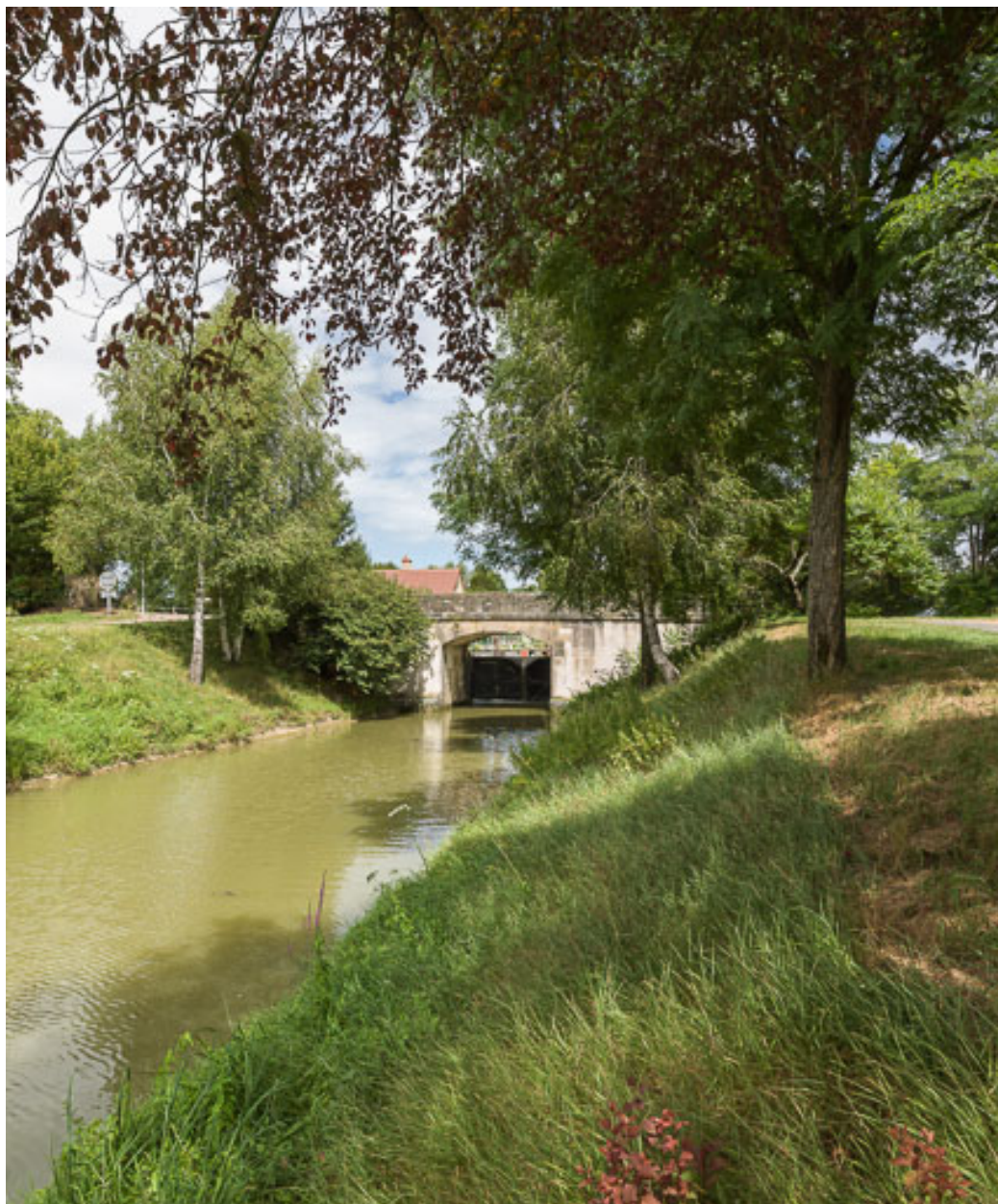
Vue du pont.
