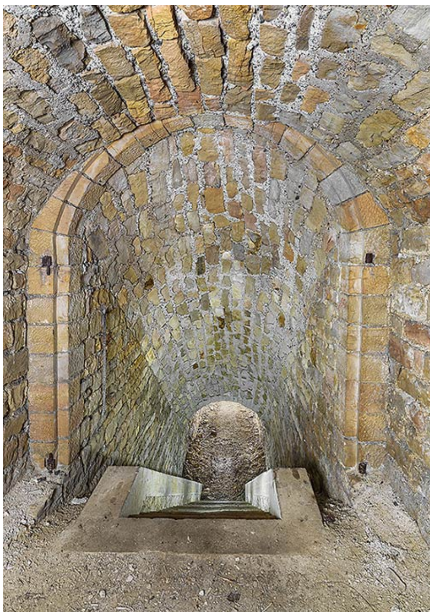
Rampe-escalier vers la double caponnière.
