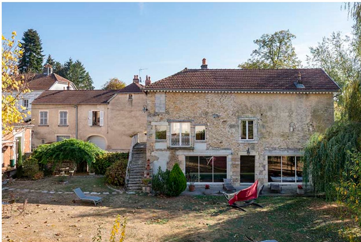
L'ancien bâtiment à usage de tannerie.
