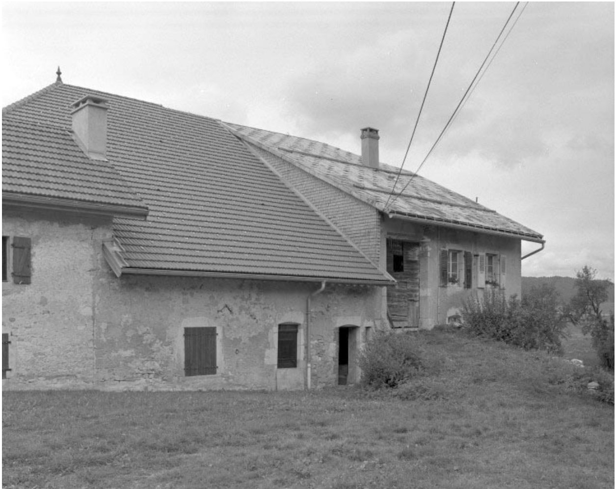
Façade sud-est, vue rapprochée avec trace du réhaussement de la partie occupée aujourd'hui par la ferme.
