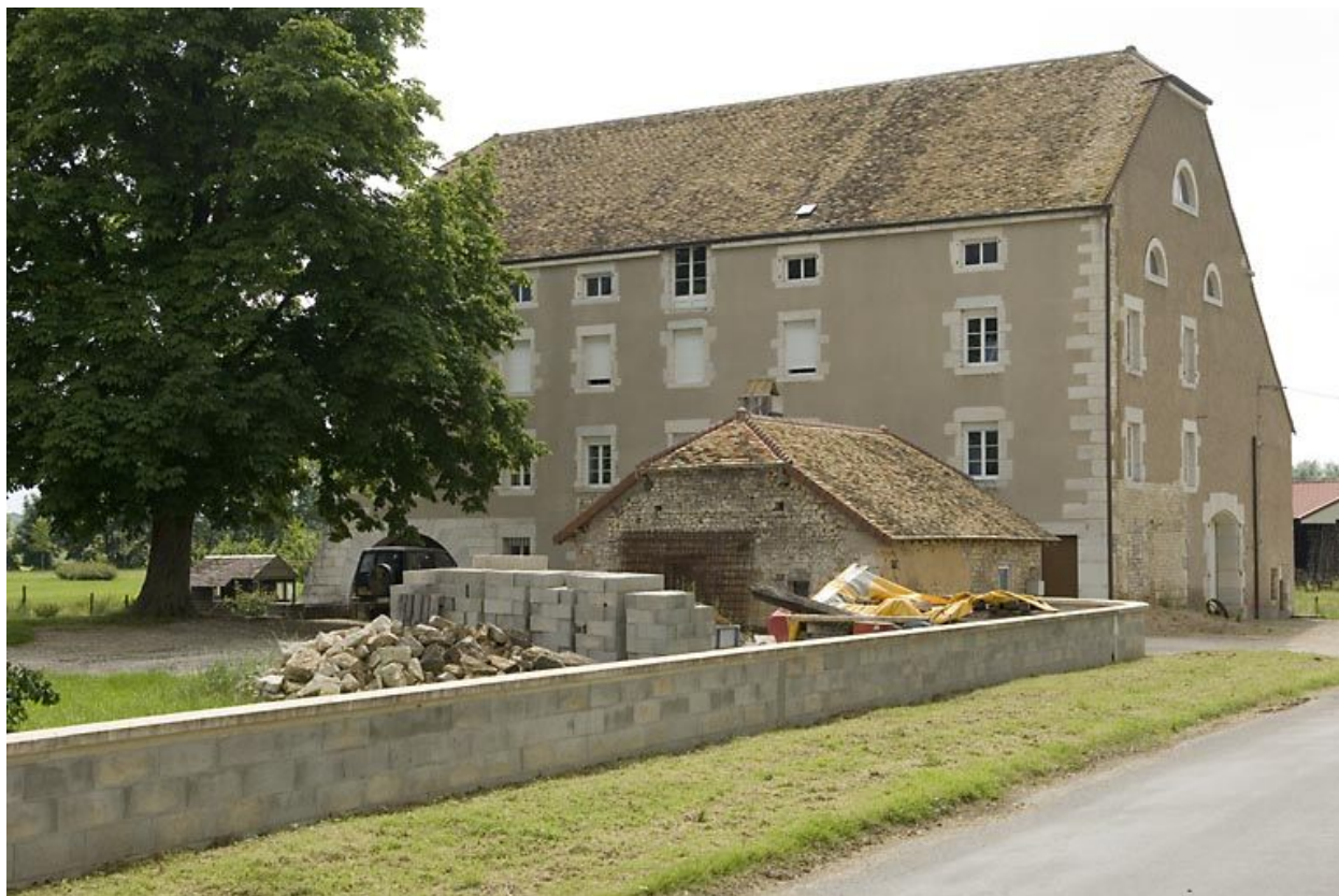
Vue du moulin depuis le nord-est.
