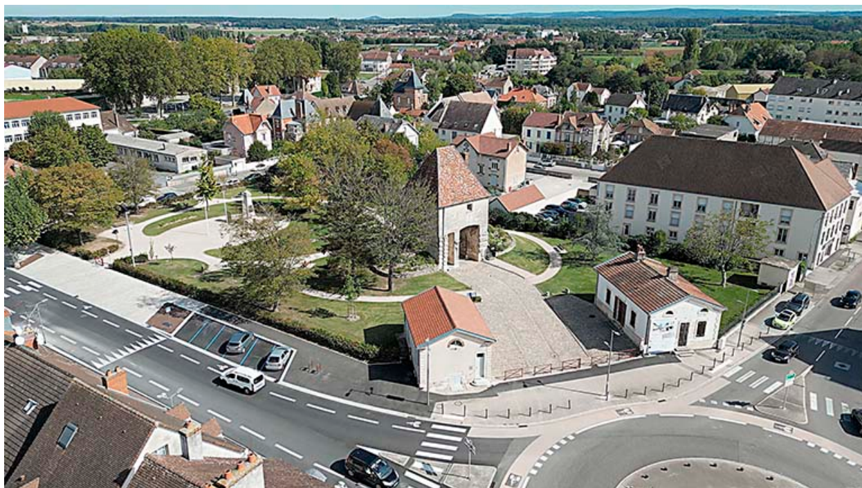
Vue aérienne de la porte de Comté.
