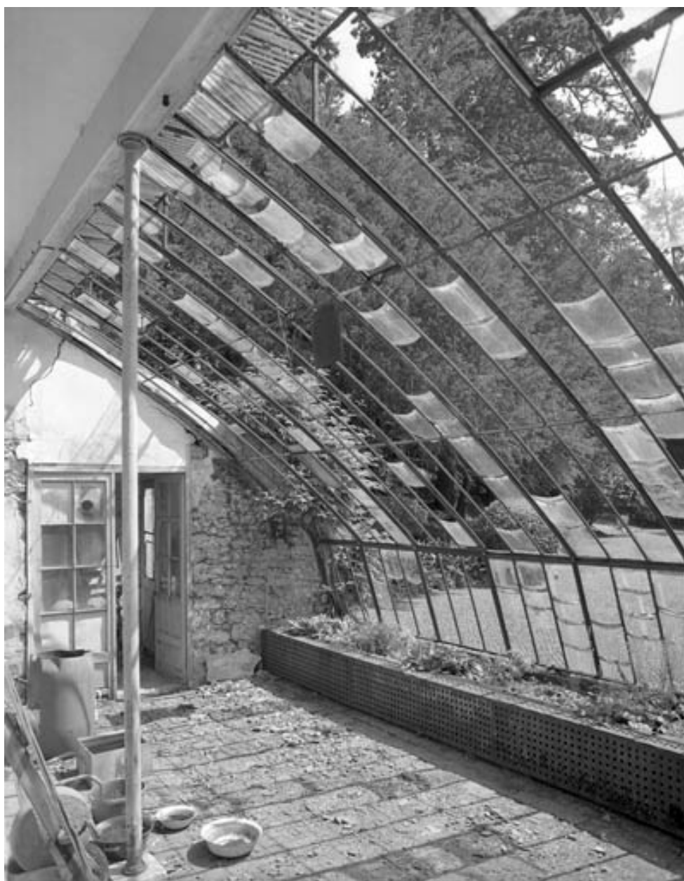
Détail de l'intérieur de la serre.
