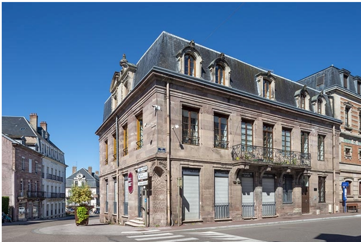
Maison Desgranges, façade sud et façade est.
