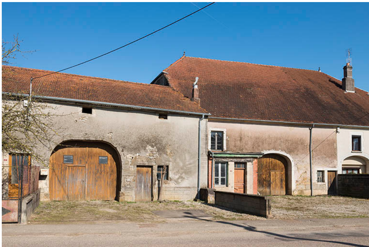
Fermes avec portes de grange.
