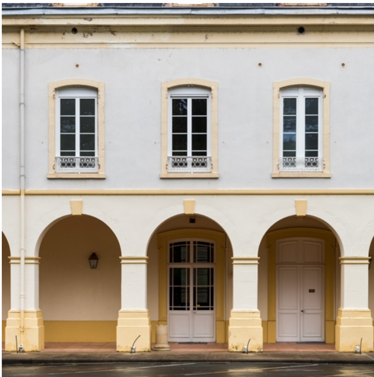
Cour, détail de l'aile nord.
