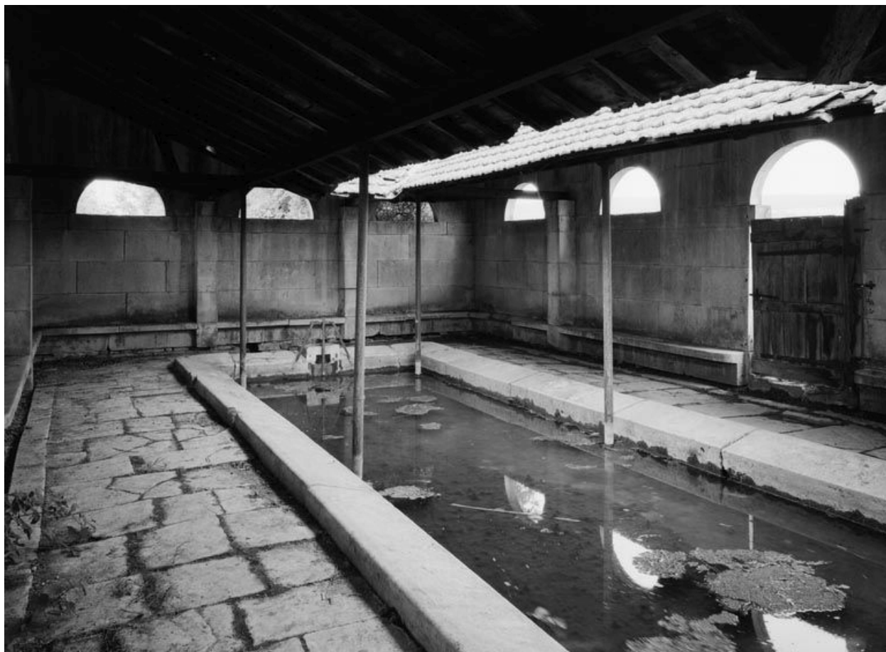
Vue intérieure du lavoir.
