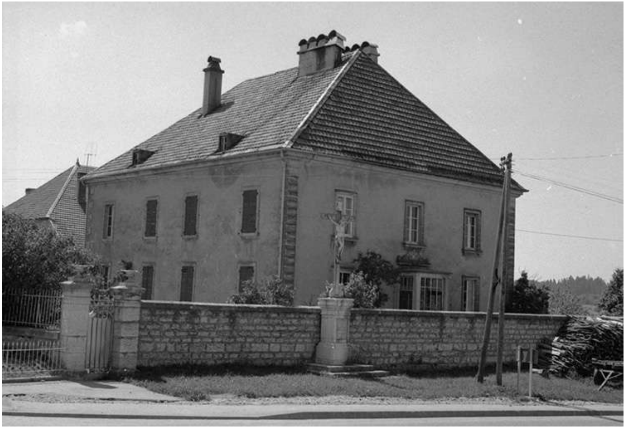
Façades antérieure et latérale gauche.
