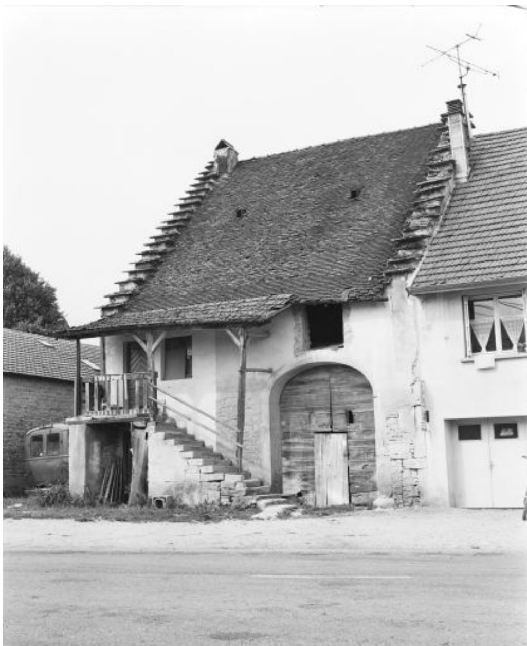
Ferme cadastrée 1951 B3 161, située rue Principale.
