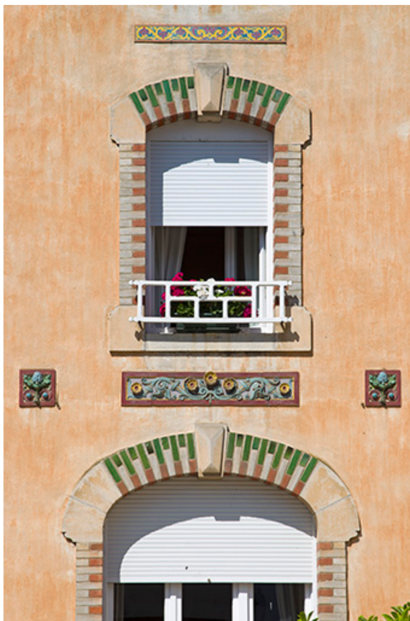
Détail de baies de l'avant-corps.
