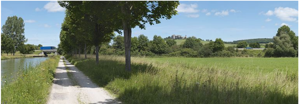
Pont autoroutier, château de Châteauneuf en arrière-plan.
