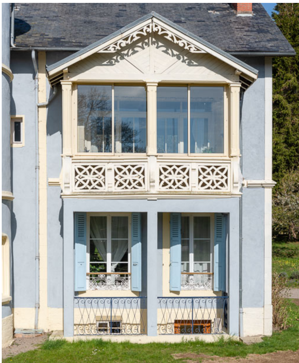
Façade sud-est, oriel.
