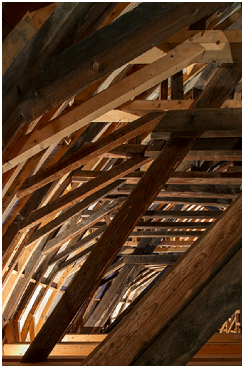
Côté sud de la charpente du dôme.
