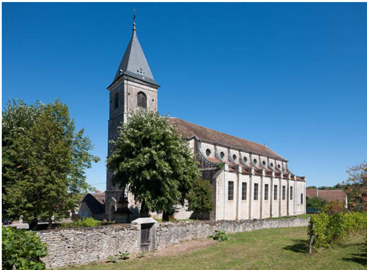
Vue générale sud-ouest de l'église
