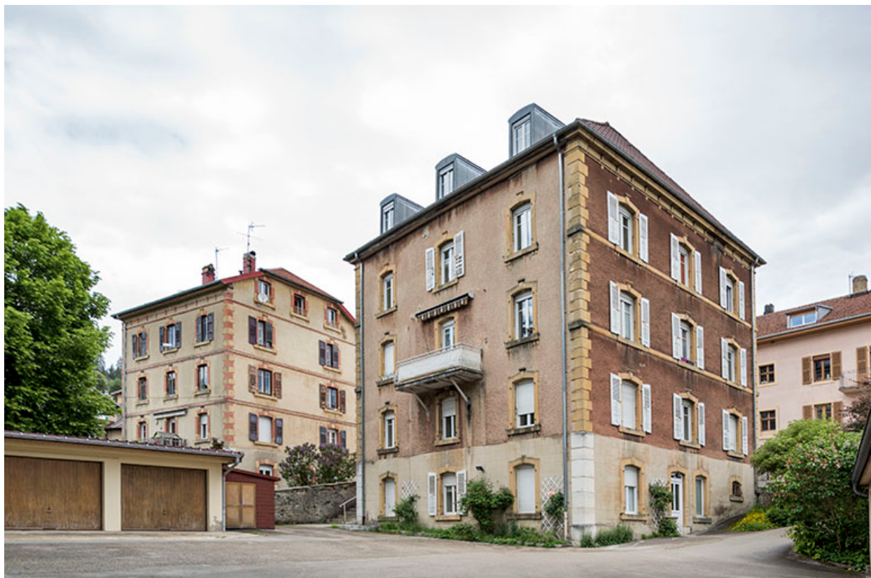
Façades postérieure et latérale gauche.
