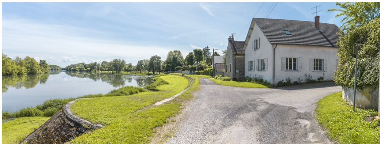
Tête aval de la digue.
