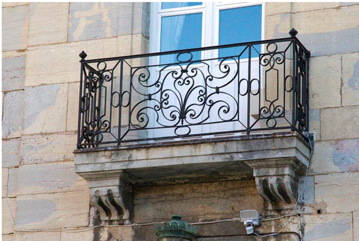
Façade antérieure, partie centrale : détail du balcon.
