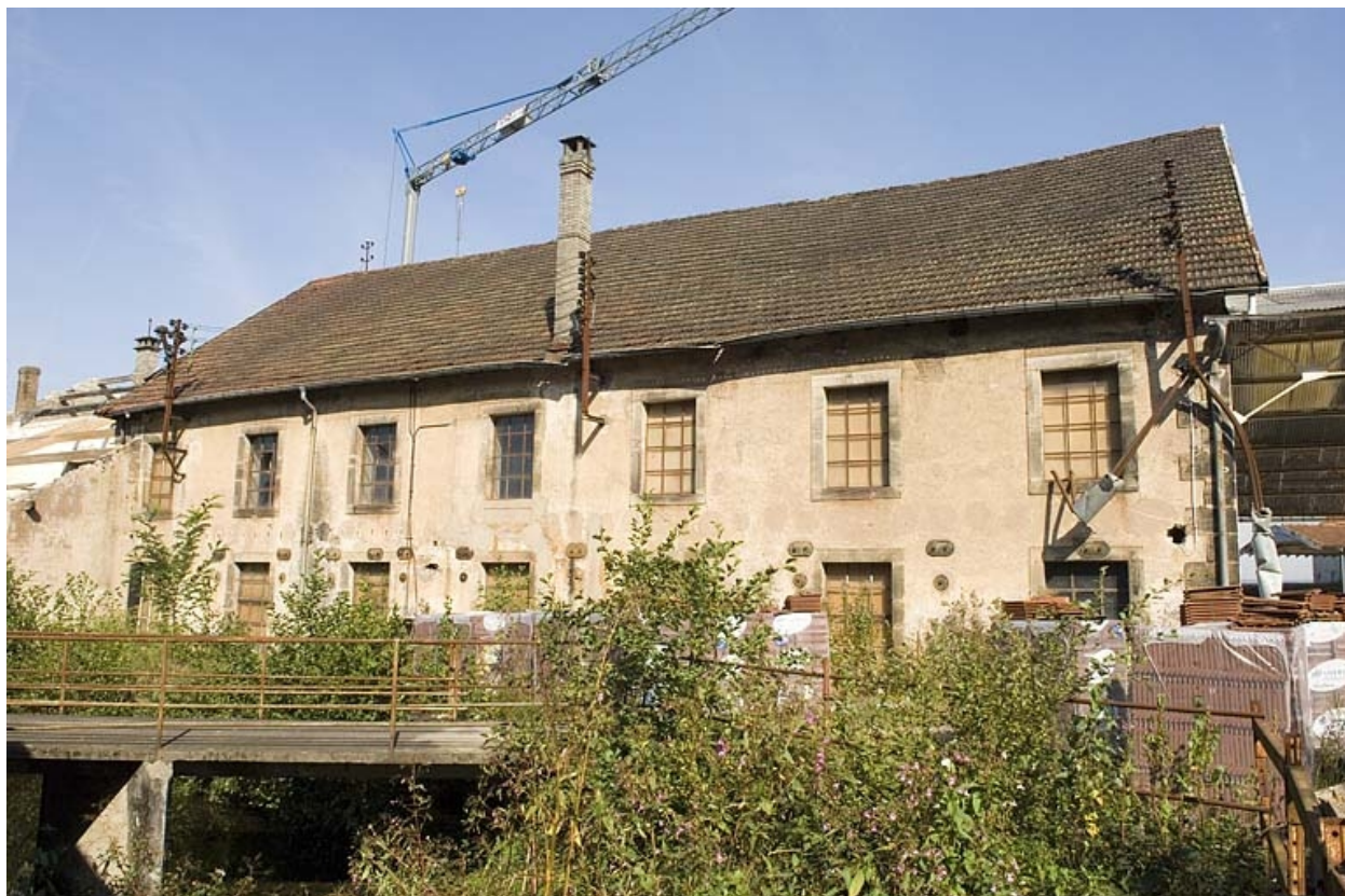
Façade sud de l'atelier de fabrication.
