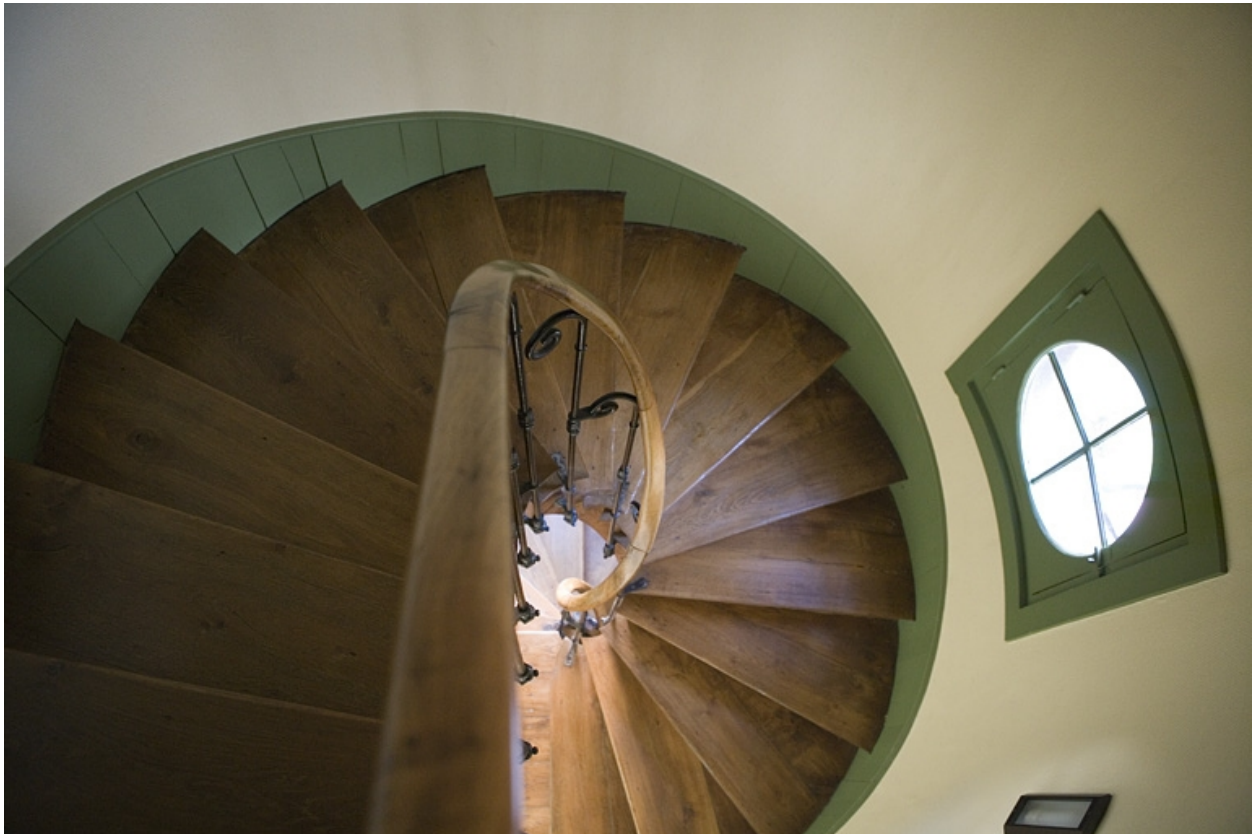
Détail de l'escalier situé dans la tour.
