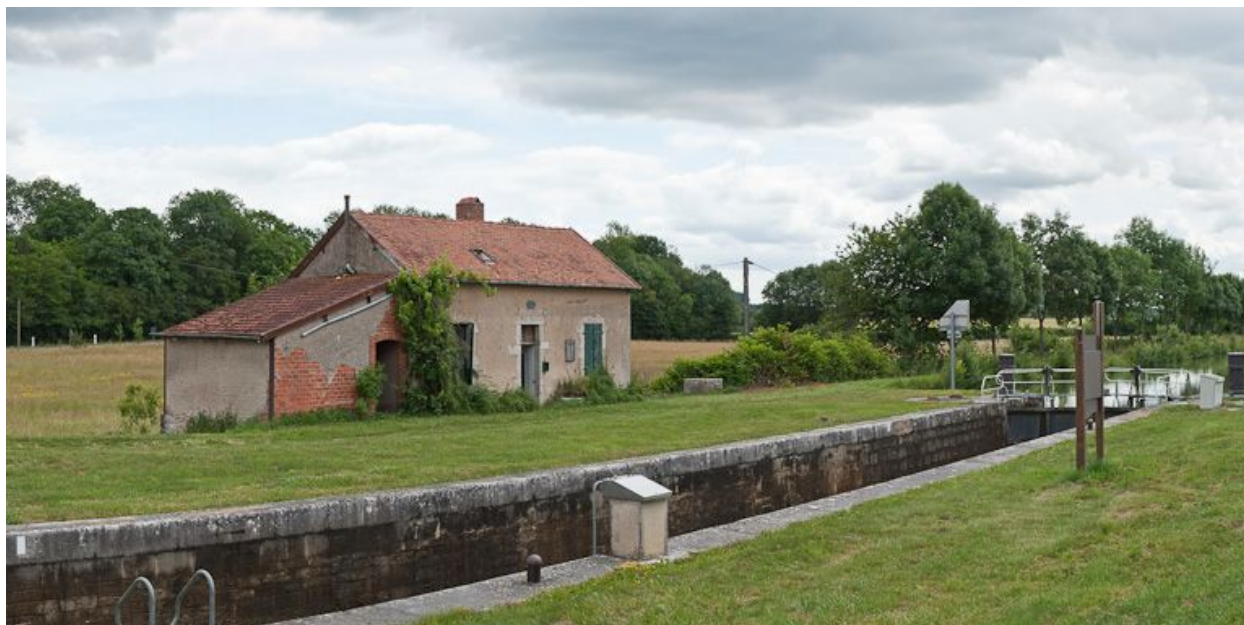
Vue d'ensemble du site d'écluse.
