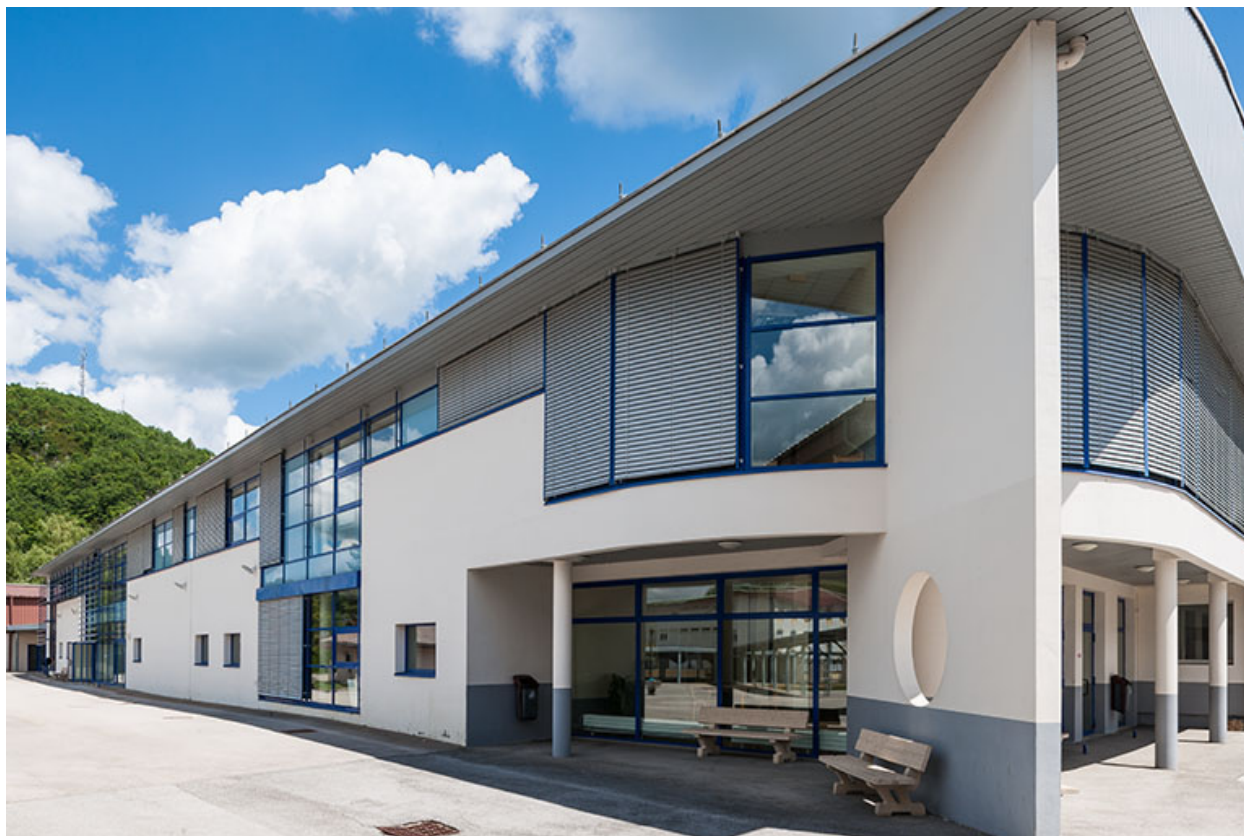
Ateliers : détail des façades et entrée.
