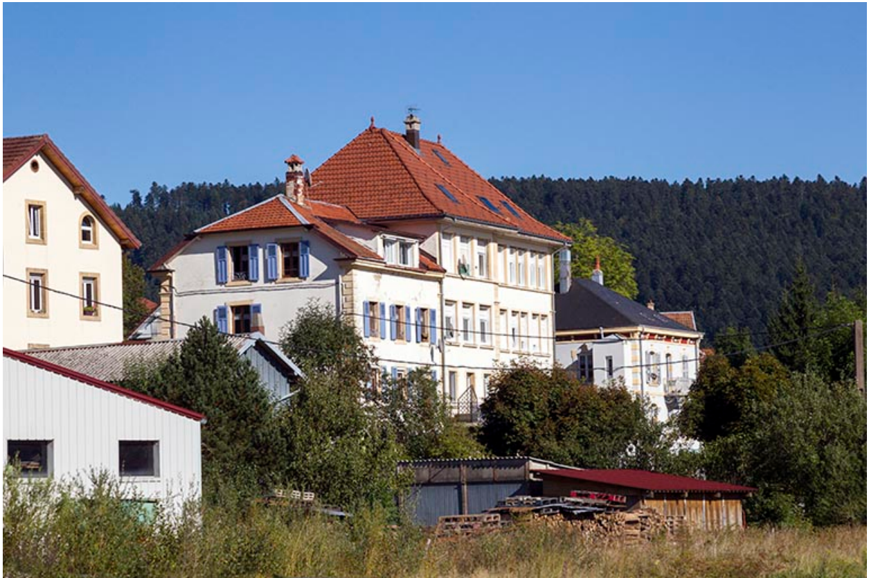
Vue d'ensemble depuis l'ouest (façade postérieure).
