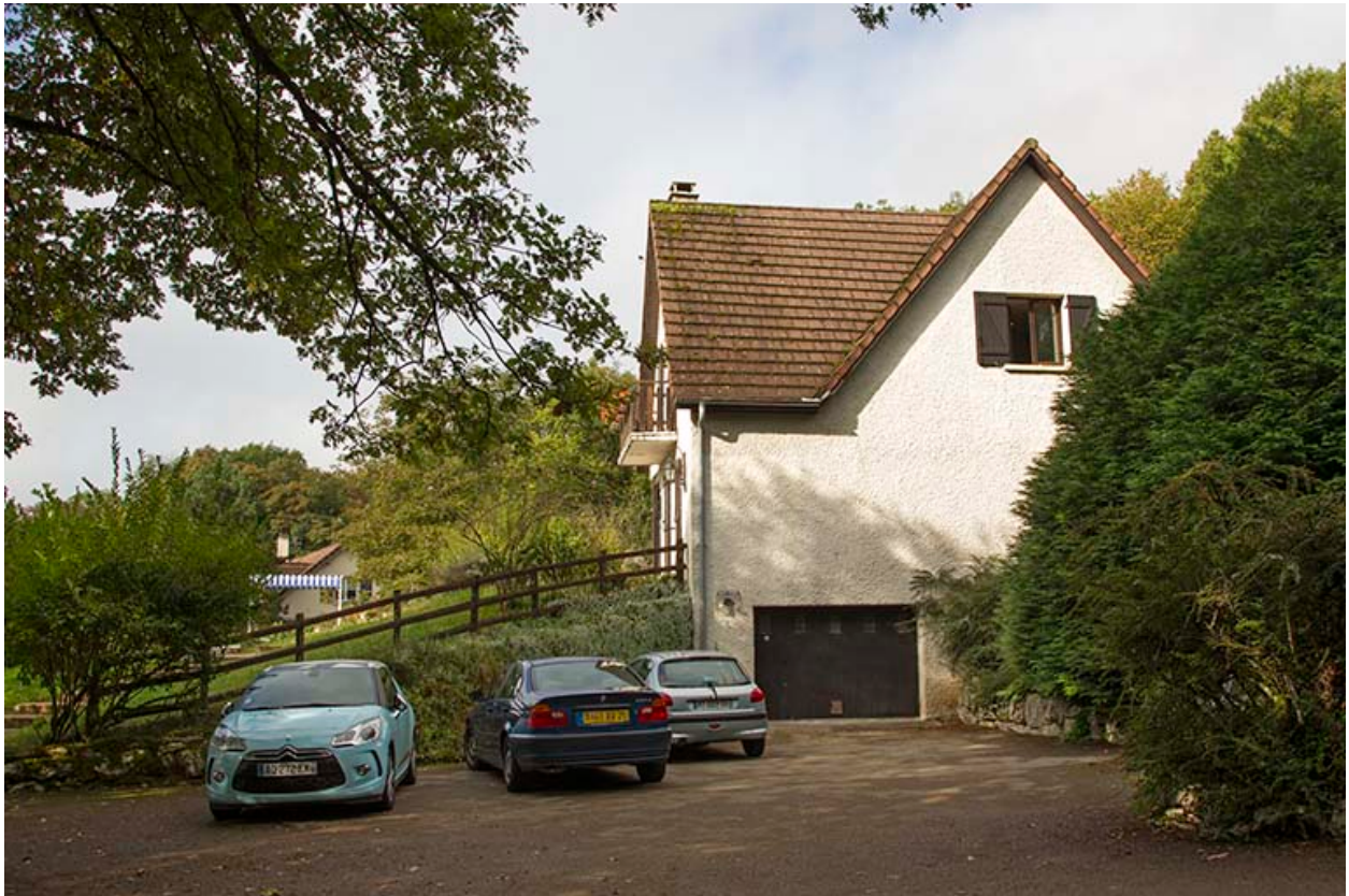
Façade latérale droite.
