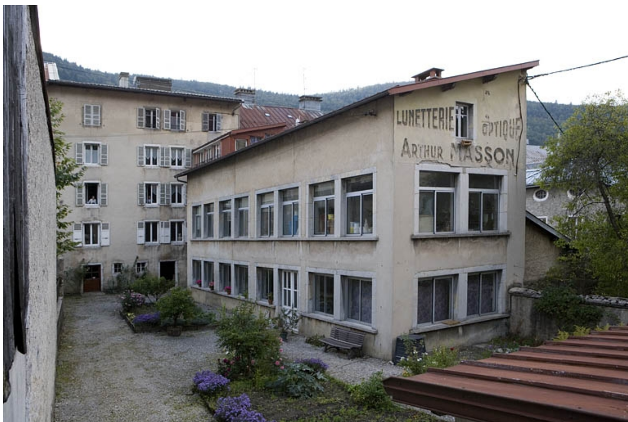
Maison de l'Email, Morez (171 rue de la République et 4 rue du Docteur Regad) : atelier rue du Docteur Regad.
