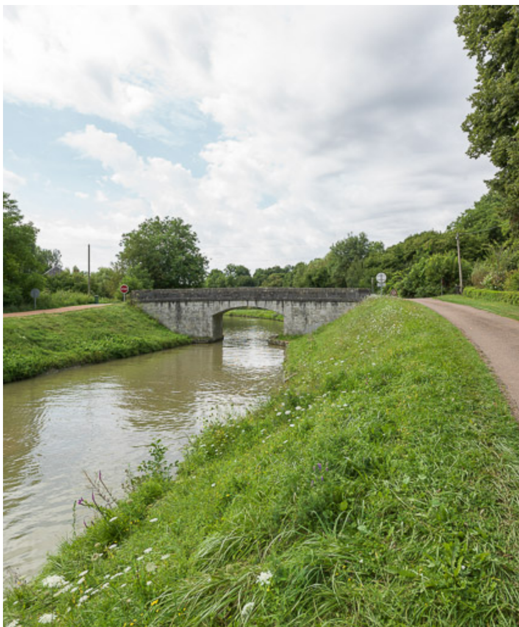
Vue d'ensemble du pont.
