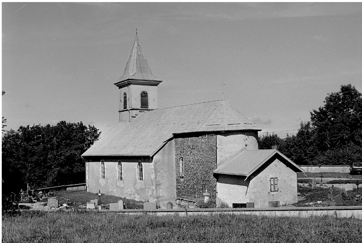
Extérieur : abside et face sud.
