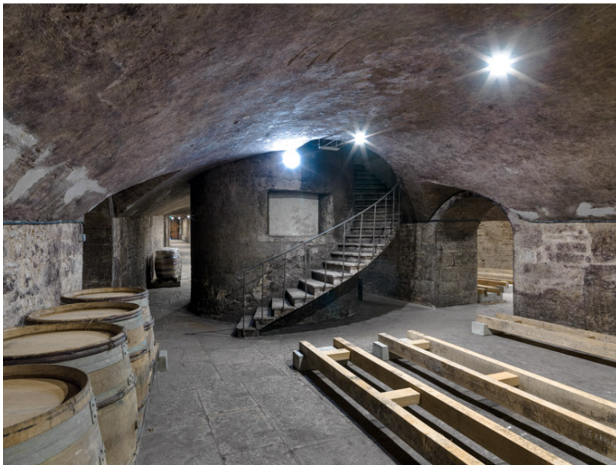
Caves, rez-de-chaussée : vaisseau central et le monte-charge.
