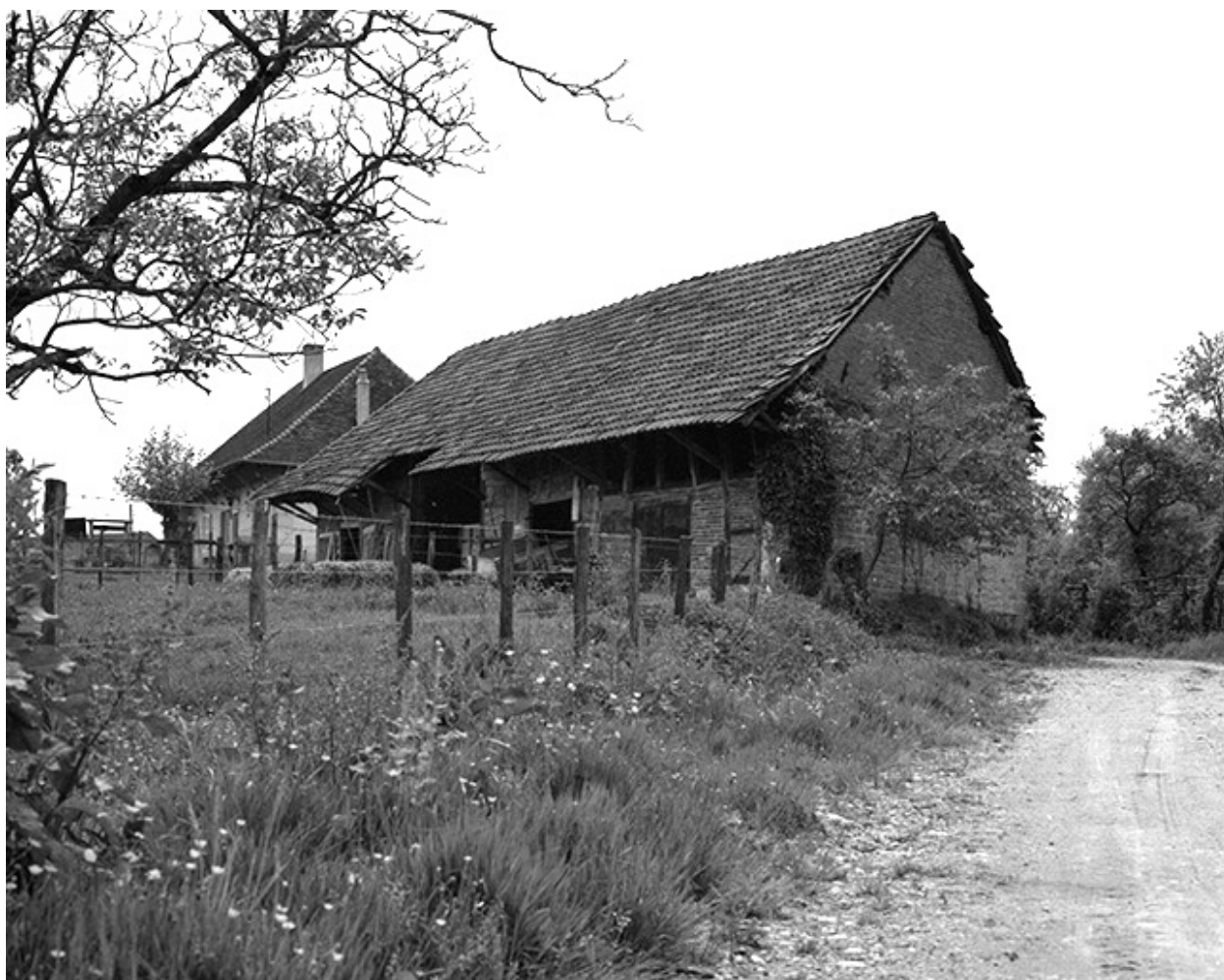
Bâtiment d'exploitation : façades antérieure et latérale droite.
