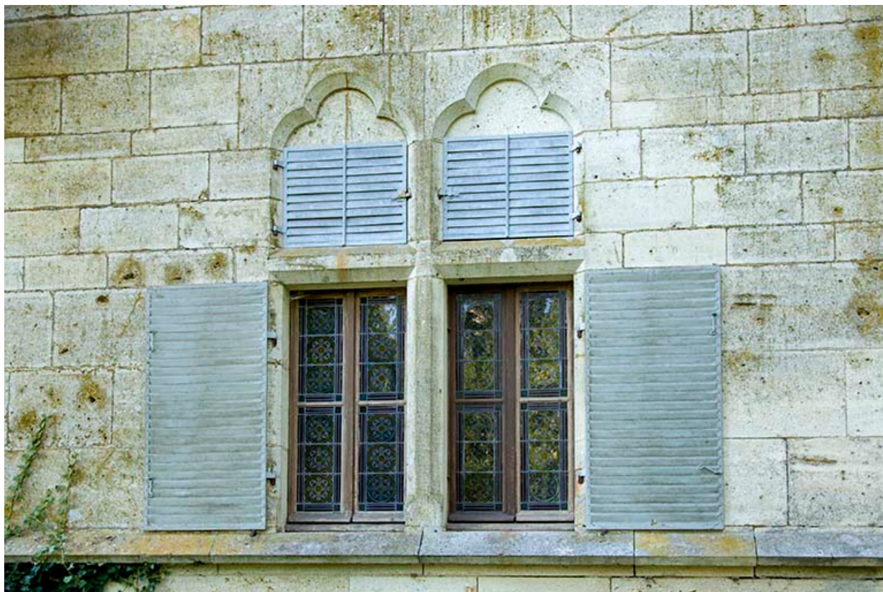
Détail : baies jumelées du 1er étage.
