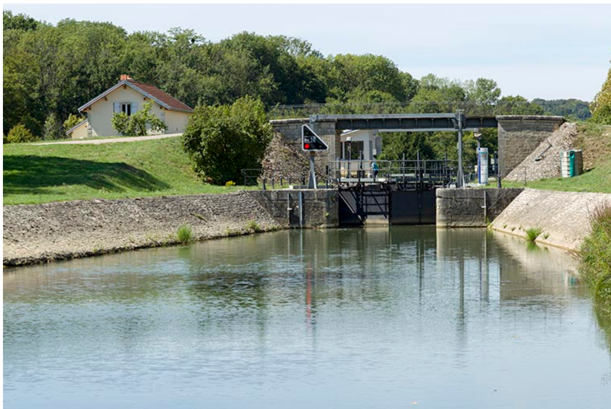
Entrée amont de l'écluse à sas.
