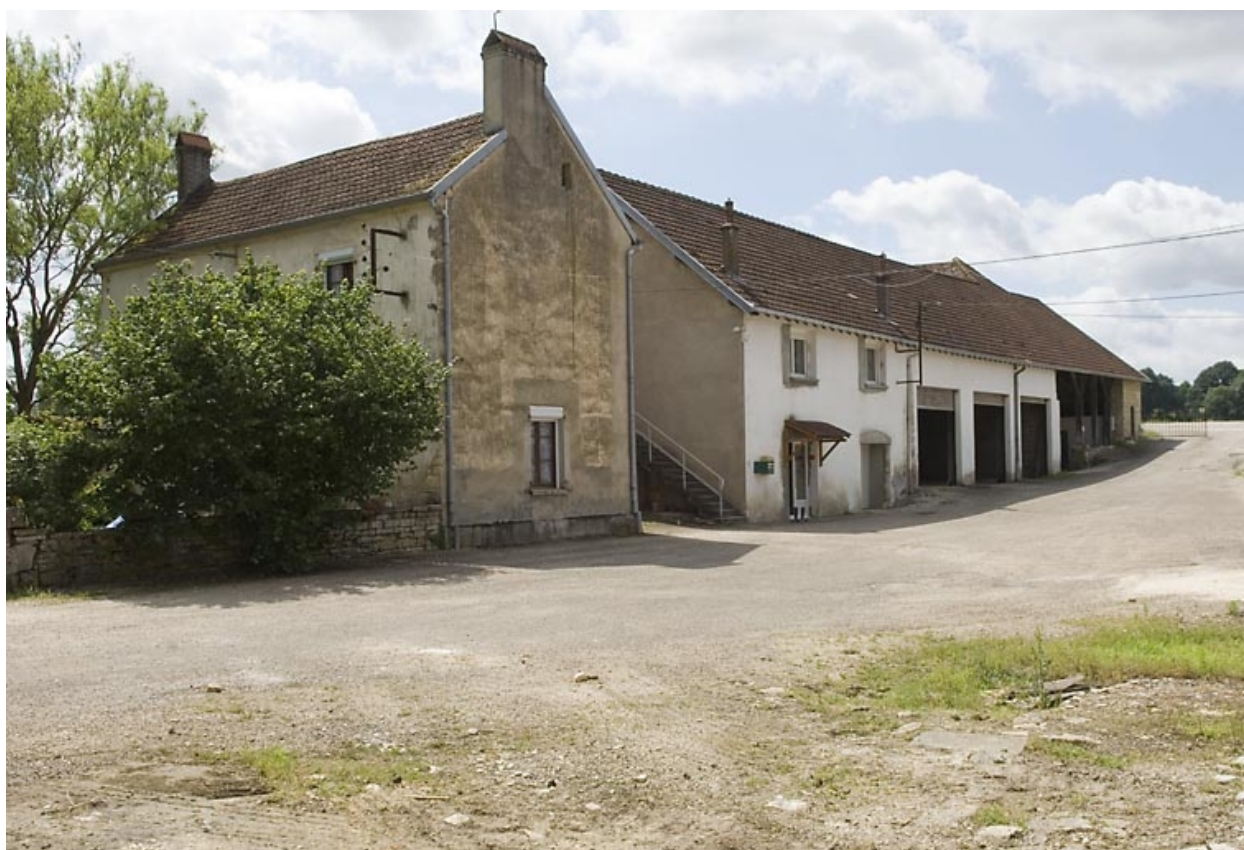
Logement et halle à charbon (remaniée).
