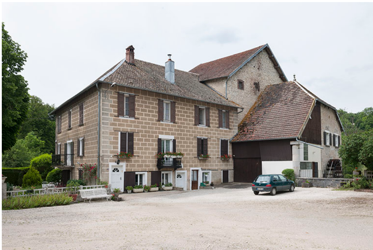
Logement et moulin depuis la cour.
