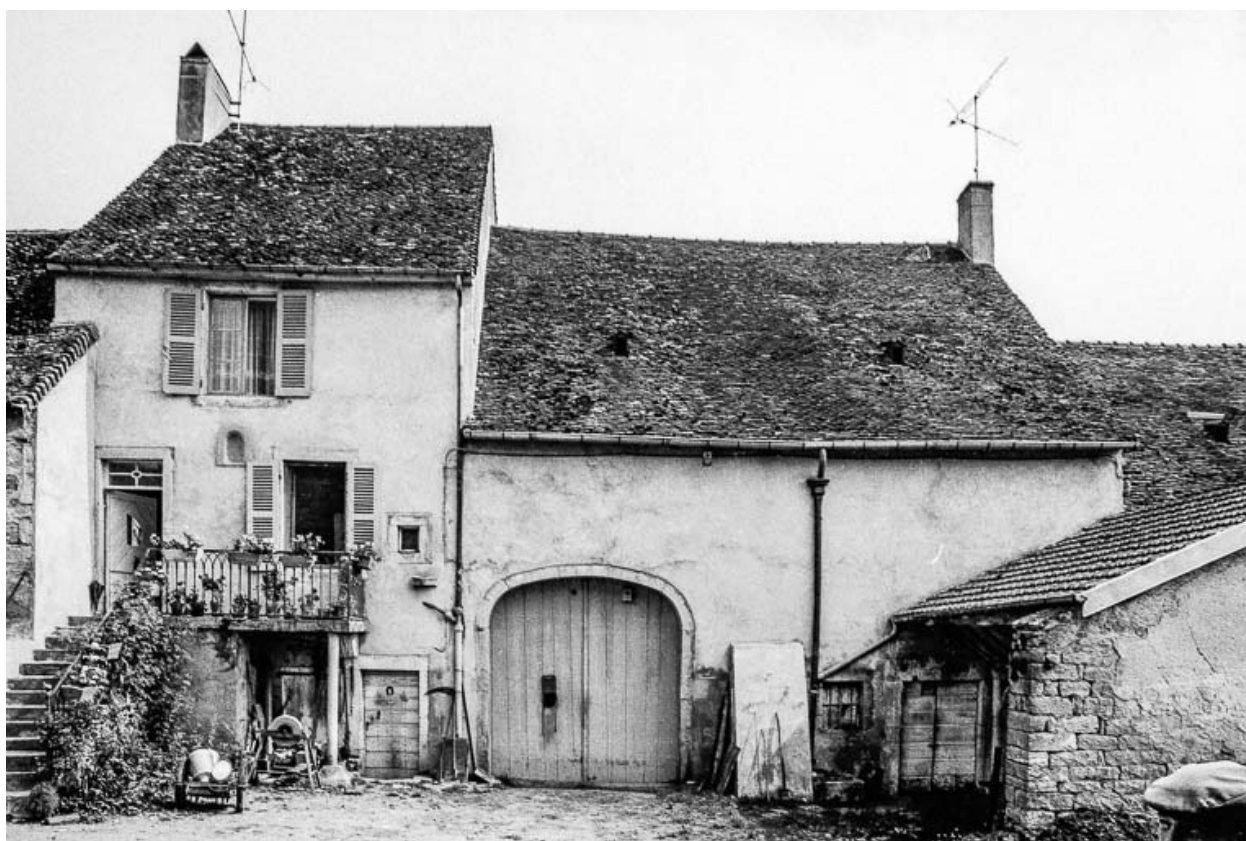
Ferme cadastrée 1964 AC 90 (droite) : façade antérieure.
