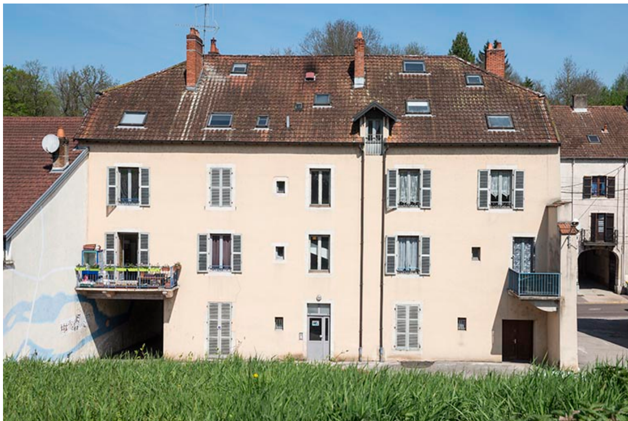
La façade postérieure.
