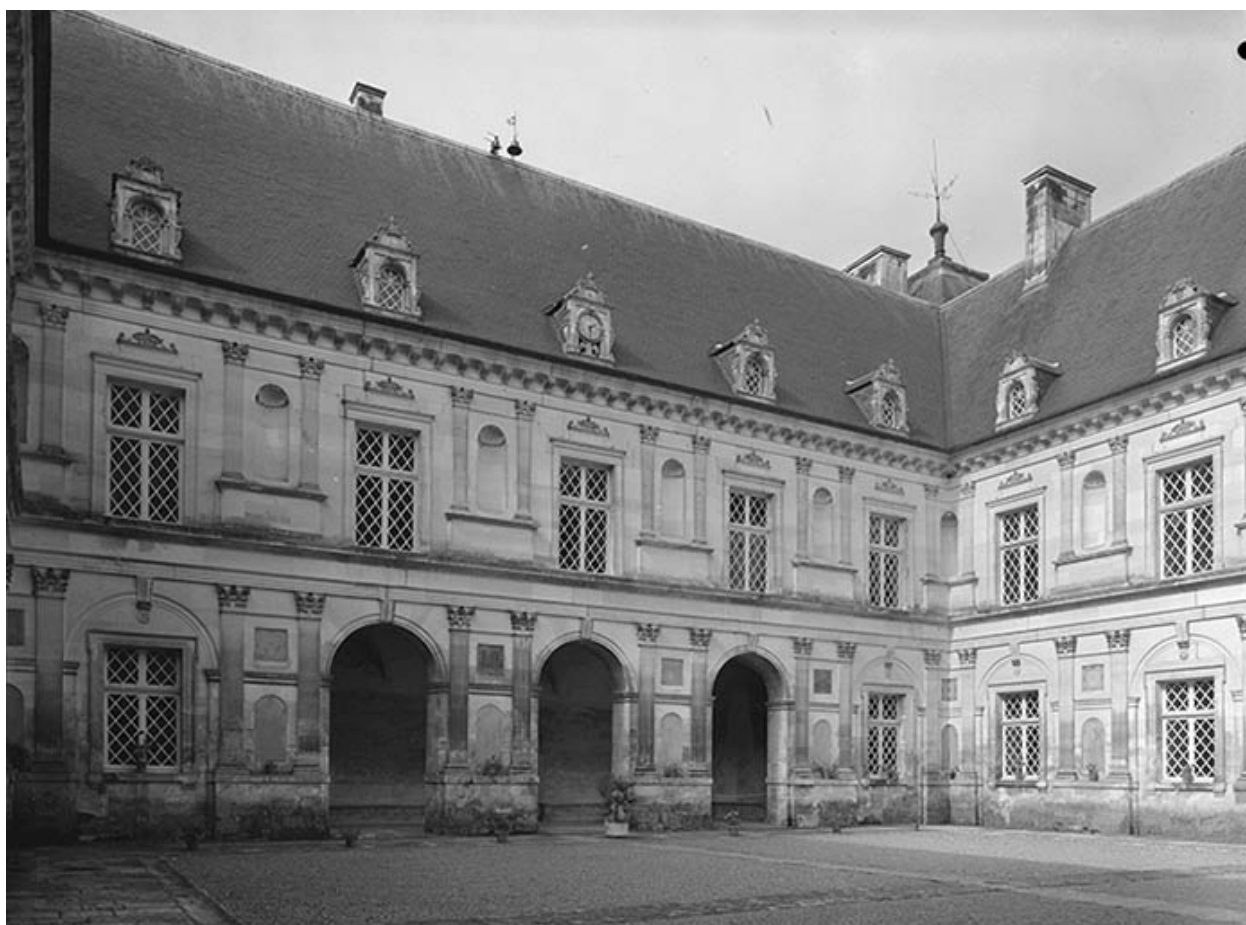
Façades sur cour (sud et ouest).
