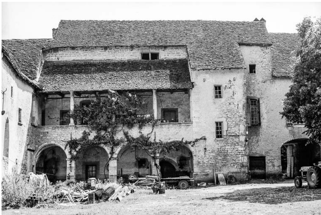
Corps de logis : la galerie.
