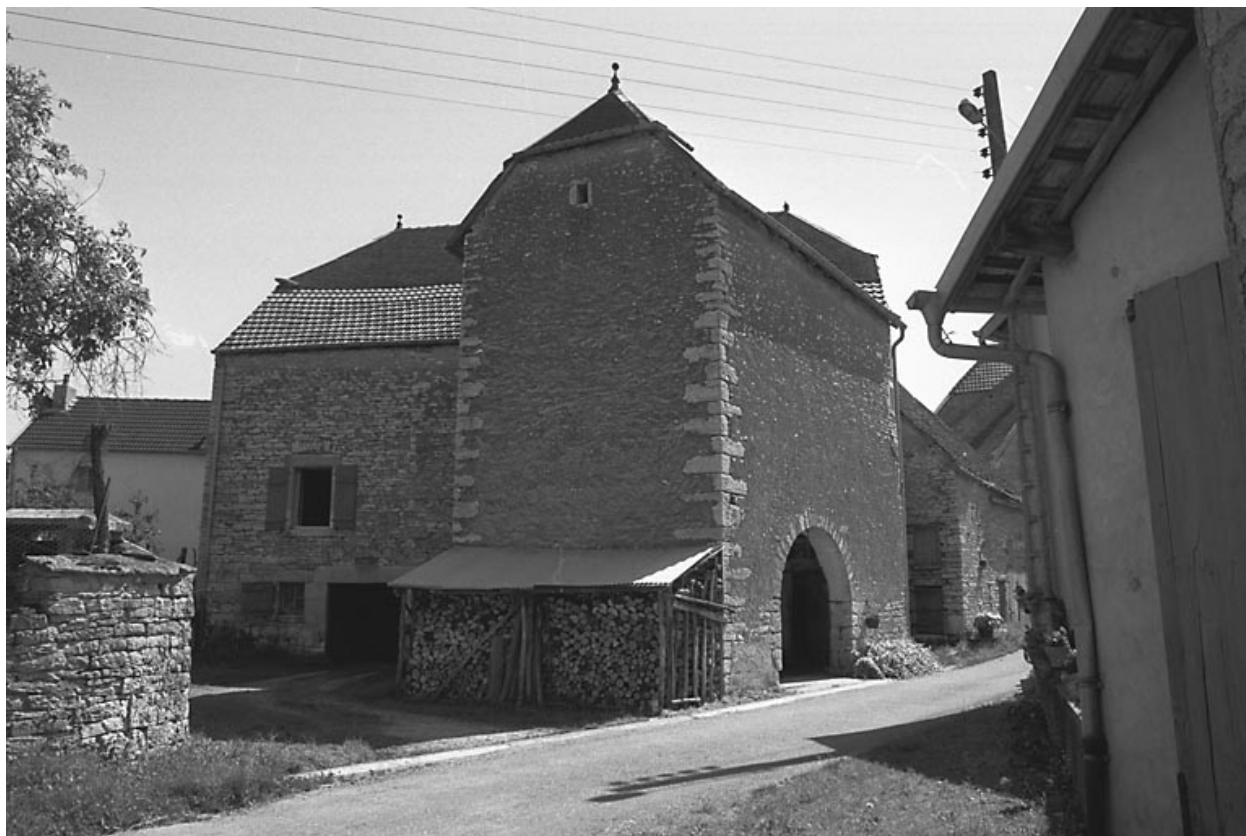
Façade postérieure du bâtiment.
