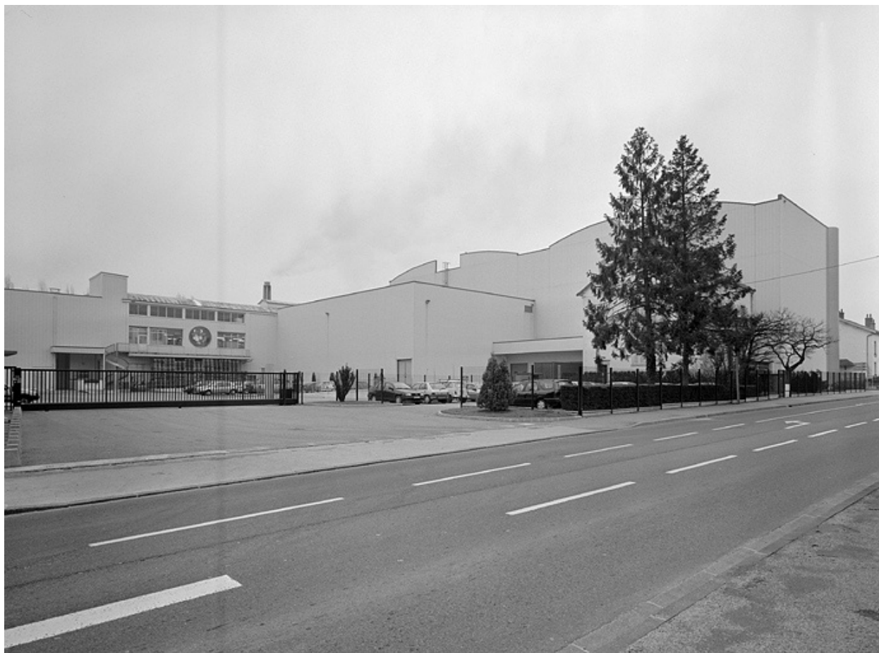
Vue d'ensemble depuis l'avenue Camille Prost.
