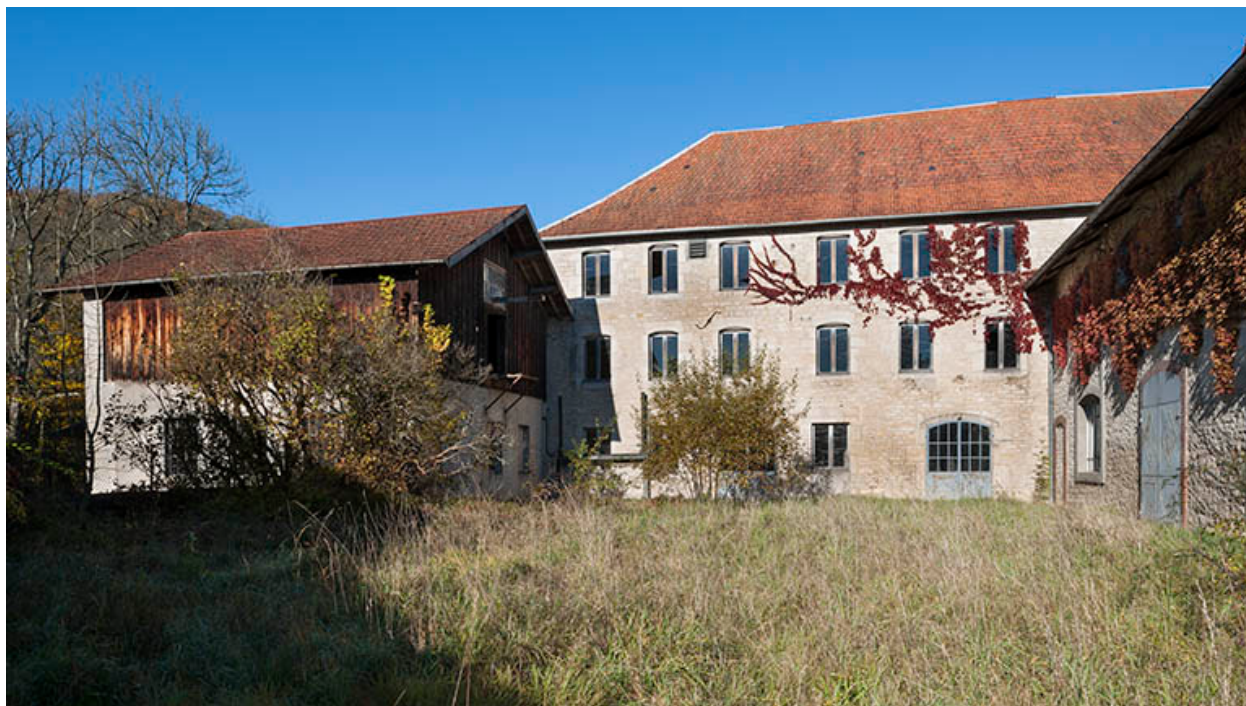
Façade sud de l'atelier.
